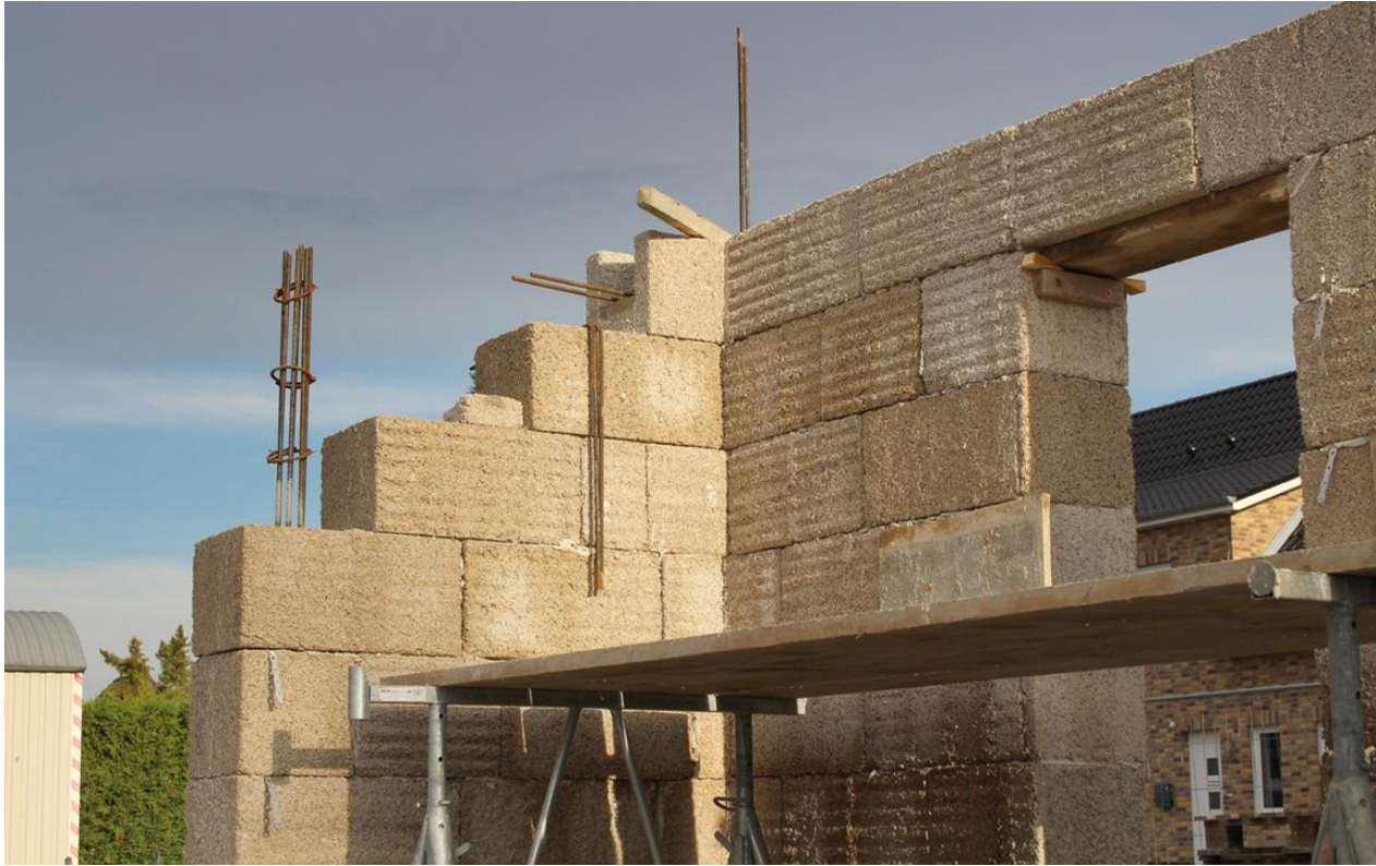
Hanfkalk Steine. Foto: Eiskamp Bauunternehmen. https://www.eiskamp-bau.de/oekologisches-bauen.html
