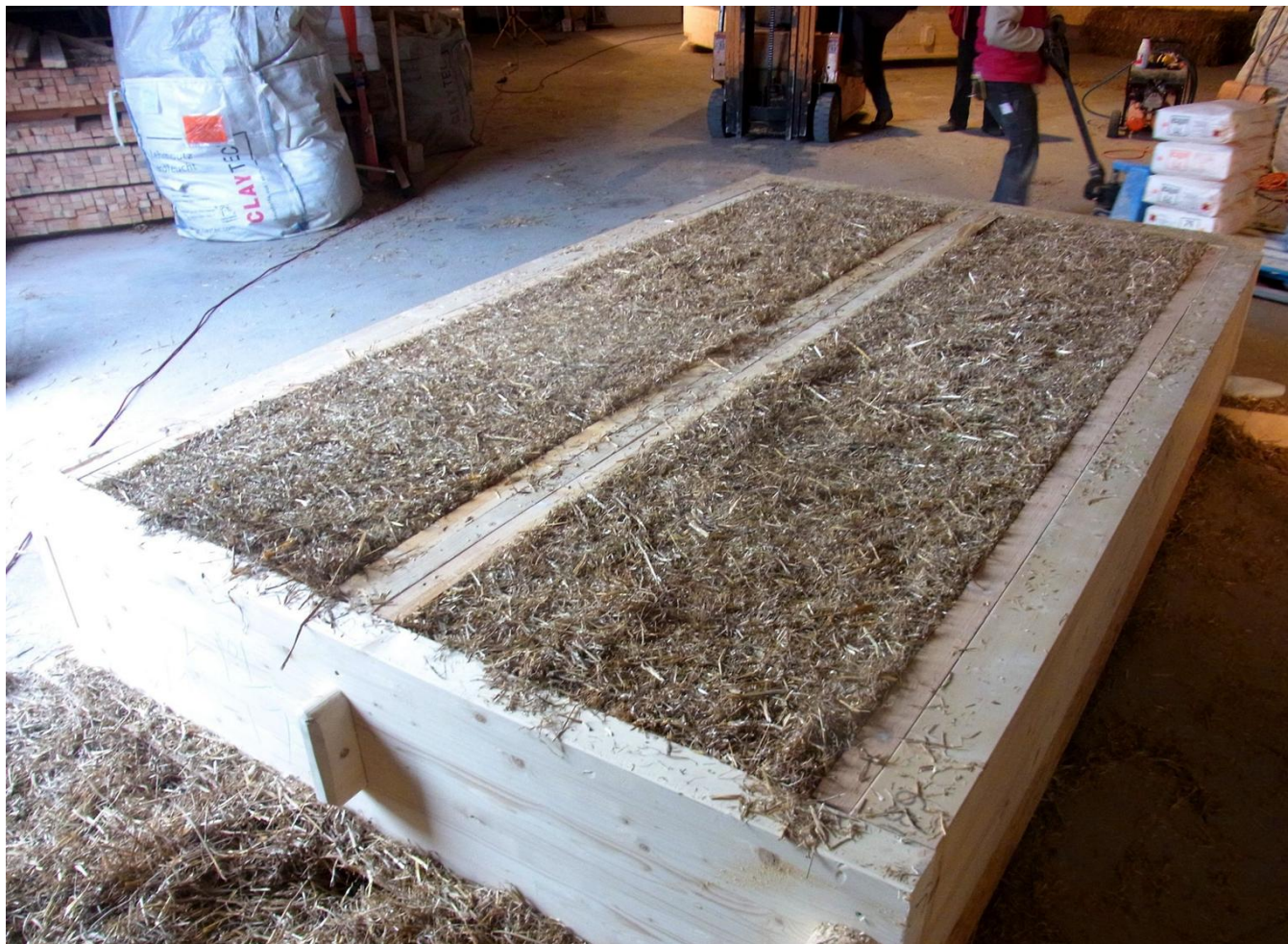
NZNB, Vorfertigung der Elemente direkt vor Ort durch https://Baustroh.de GmbH Baudokumentation: https://www.youtube.com/watch?v=ZHI8n42AJzE
