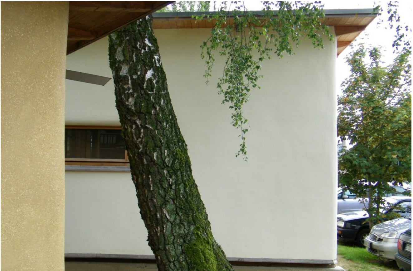
Abbildung 2: Energie- und ressourceneffiziente Strohhäuser rund um das Norddeutsche Zentrum für Nachhaltiges Bauen in Verden. Foto: Michael Burchert
