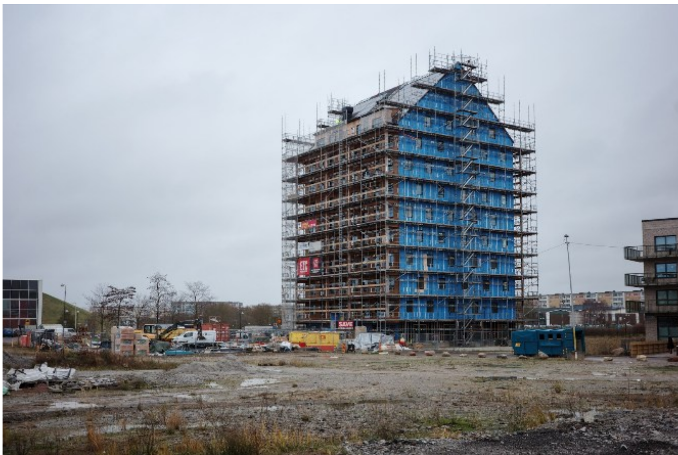
Abbildung 5: Höchstes „Strohhaus“ derzeit in Fertigstellung in Malmö mit vorgefertigten Strohmodulen. Foto: Dan Hill
