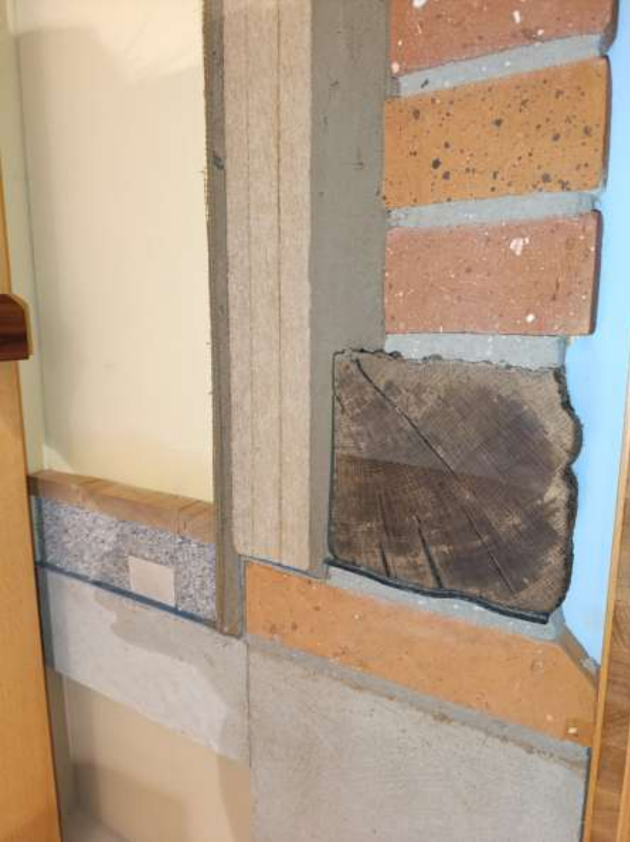
Innendämmung, Holzweichfaser, Perlite, Lehm Wandschnitte in der Ausstellung am https://nzn.de
