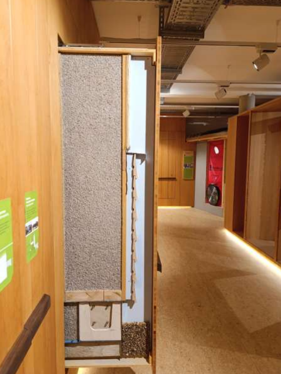
Zellulose, Holzweichfaser Wandschnitte mit verschiedenen Fassaden in der Ausstellung am https://nznbn.de
