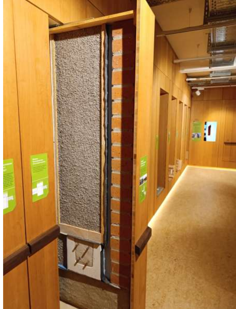
Zellulose, Holzweichfaser Wandschnitte mit verschiedenen Fassaden in der Ausstellung am https://nznbn.de
