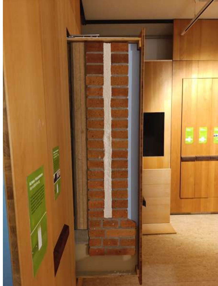
Innendämmung, Holzweichfaser, Perlite, Lehm Wandschnitte in der Ausstellung am https://nzn.de
