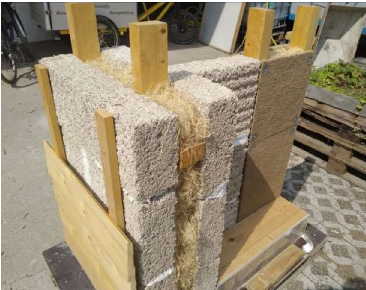
Beispiel: Holzrahmenbau mit Hanfkalk „Hempcrete“ und Hanffaser, Innenwand mit Hanflehmtrockenbau, Holzfassade Modell: https://hanfbaukollektiv.com
